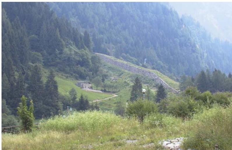
**Figura H.8-** *Opere di difesa passiva in zona di arresto: argine di deviazione.*
