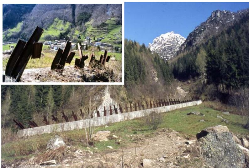
**Figura H.5 -** Zona di arresto della valanga ripresa nella primavera 1977. E' visibile il muro di contenimento realizzato in zona di arresto all'inizio degli anni settanta, nonché i danneggiamenti alle putrelle di estremità prodotti dall'evento del 1972.
