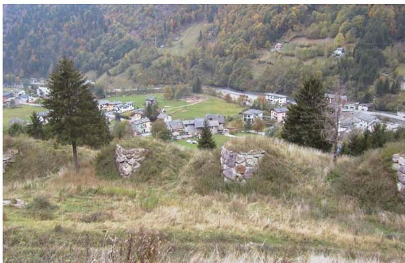
**Figura H.9** *Opere di difesa passiva in zona di arresto: cunei di rallentamento*
