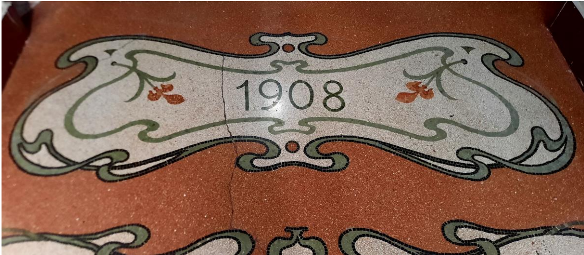
Fig.5 – Particolare pavimentazione dell'androne
