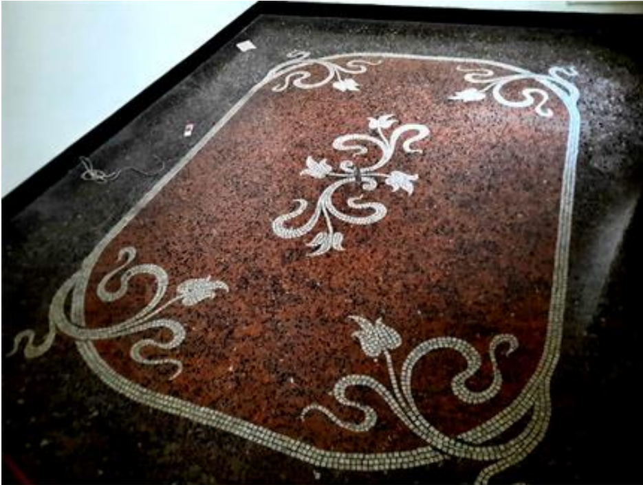
Fig. 9 – Particolare della pavimentazione in graniglia genovese (foto di F. Fazio)
