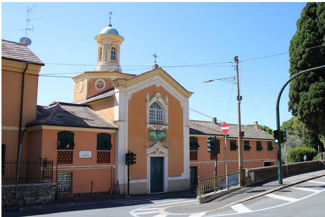
Fig. 1 – Fronte su via Aurelia: al centro la facciata della Cappella
