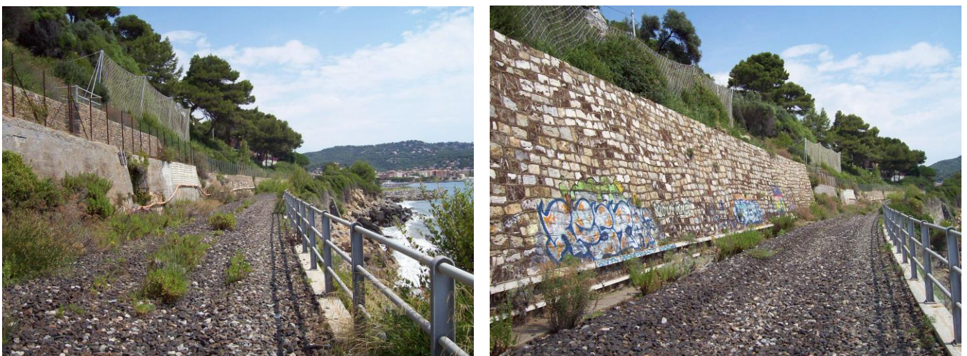
Figura 1 – porzione di tratta a picco sul mare con i caratteristici muri di sostegno in conci di pietra
