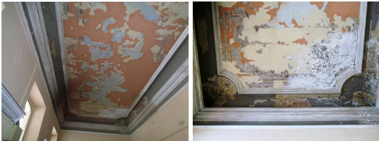
Figura 9 - decorazioni pittoriche di gusto liberty rinvenute sul soffitto della ex Biglietteria al di sotto dello scialbo
