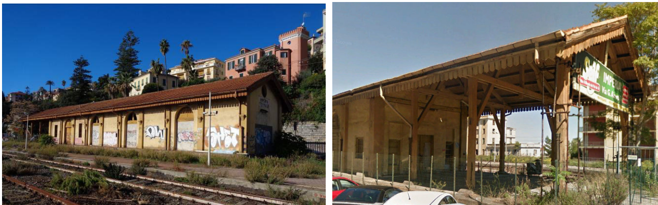
Figura 10 - magazzino merci con in evidenza la tettoia in carpenteria lignea
