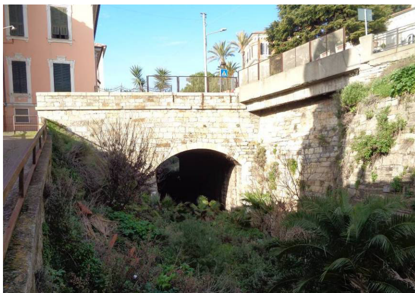
Figura 1 - imbocco della Galleria Oneglia Uno e tratto di muro di sostegno lungo il percorso
