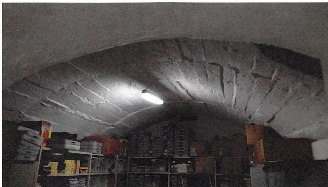
34) Laboratorio preparazioni officinali di prodotti erboristici: antico locale con volta a botte
