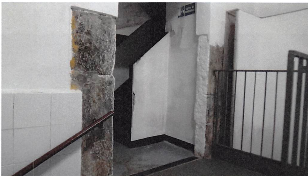
36) Laboratorio: muratura antica in pietra
