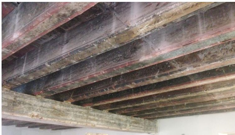
Il solaio fotografato nel marzo 2018, prima del restauro
