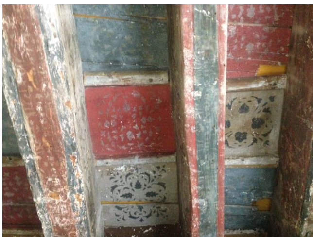
Dettaglio delle decorazioni del solaio (marzo 2018)
