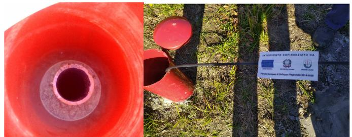
Note. Prima lettura falda a - 7,93m. Installazione sonda freatimetrica automatica 13/02/2019
