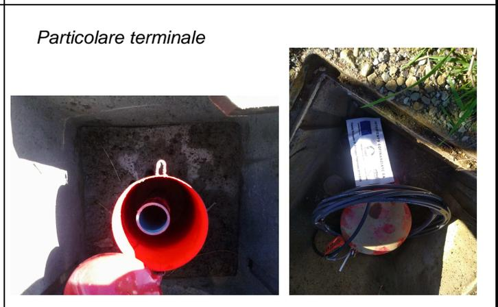
Note. Prima lettura falda a - 2,75m. Installazione sonda freatimetrica automatica 12/03/2019
