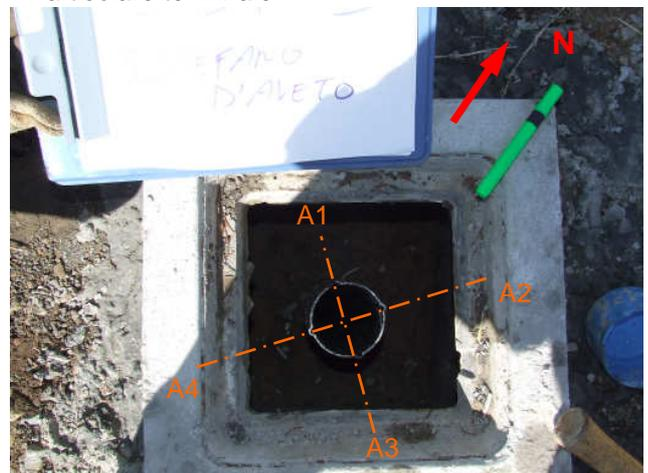
Note: Il pozzetto di protezione risulta insufficientemente cementato.
