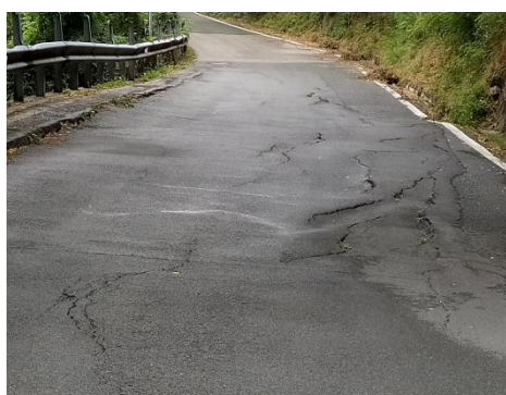
Fig. 10 - Fessure di trazione sull'asfalto in loc. Vallepiana riscontrate nel dicembre 2021 (a sinistra), blocchi di roccia plurimetrici non in posto in prossimità della sede stradale - loc. Belvedere (a destra).
