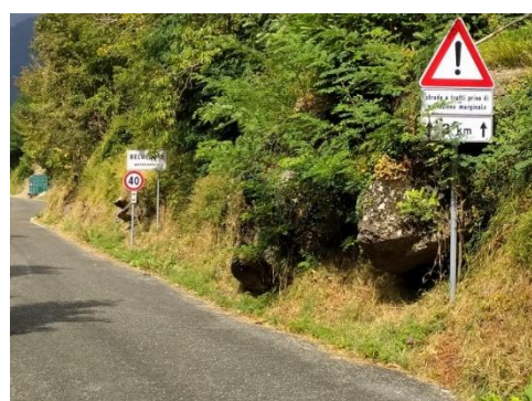
Fig. 10 - Fessure di trazione sull'asfalto in loc. Vallepiana riscontrate nel dicembre 2021 (a sinistra), blocchi di roccia plurimetrici non in posto in prossimità della sede stradale - loc. Belvedere (a destra).
