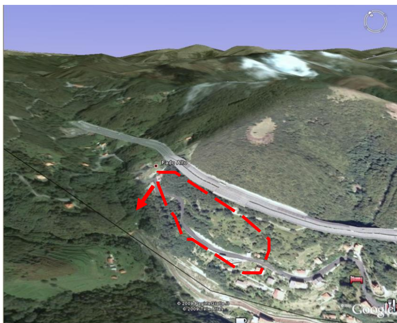
Fig. 3 - Area in frana che insiste sull'abitato del Fado e sulle sedi stradale e autostradale (direzione di movimento allo stato attuale evidente solo in una zona).
