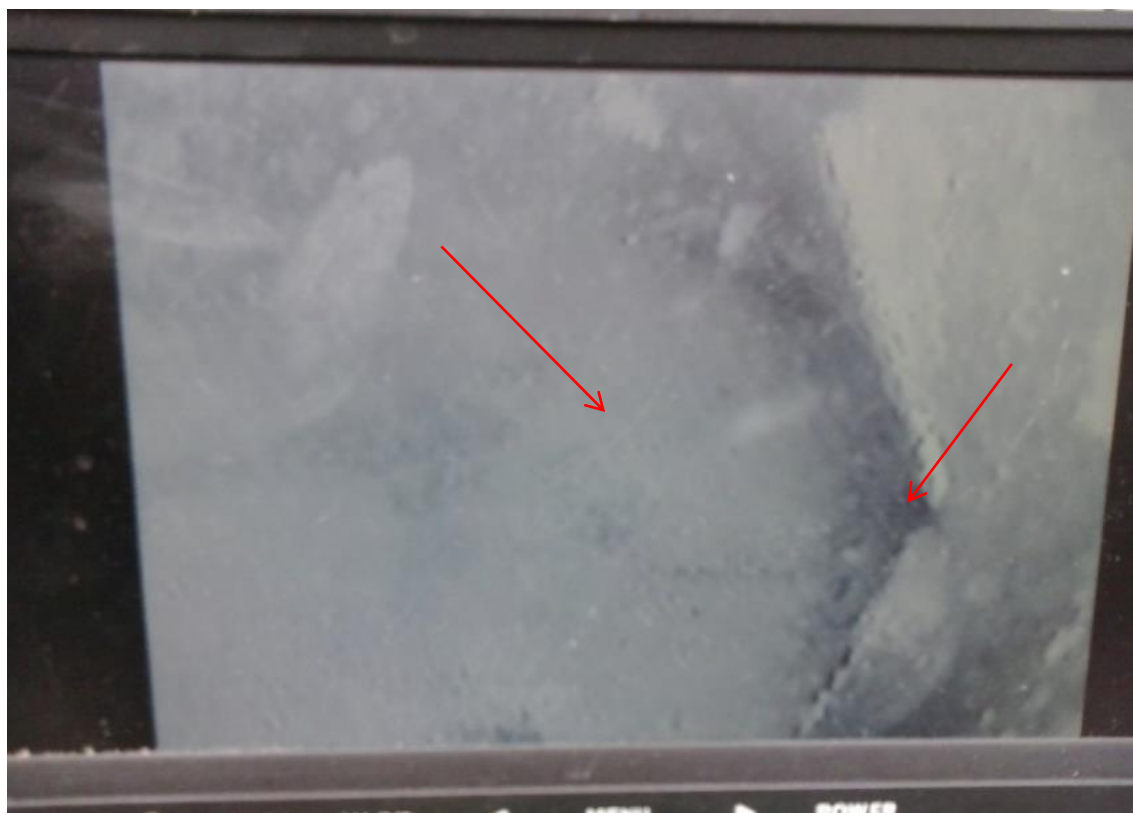
Fig. 9 – Deformazione e rottura dell'inclinometro a -48m di profondità. Le due frecce rosse indicano la zona ove la tubazione inclinometrica verticale si è irrimediabilmente piegata verso destra.
