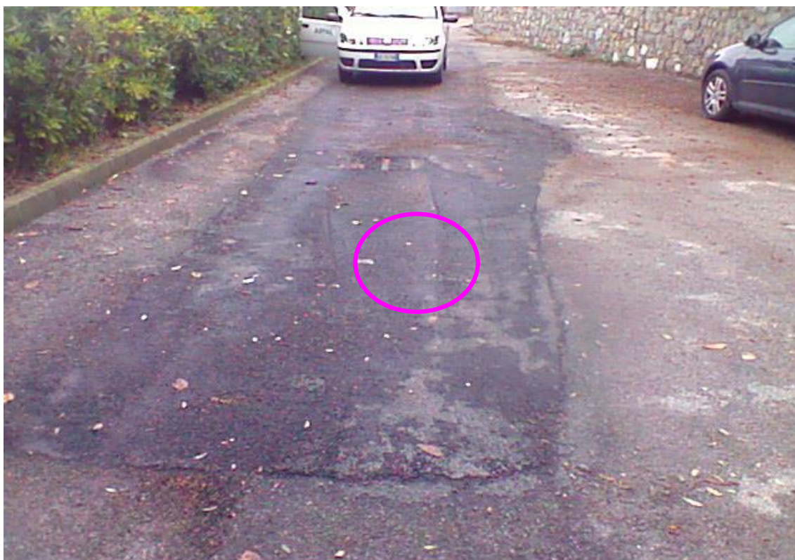
Fig. 8 - Estensione dell'area asfaltata e punto in cui è ubicato S15
